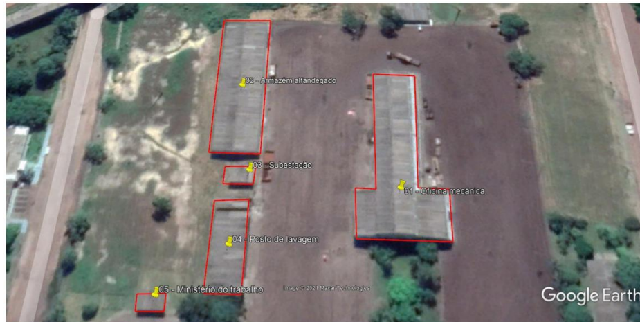
Figura 1 – Estruturas existentes no VDC04 Fonte: CDP
